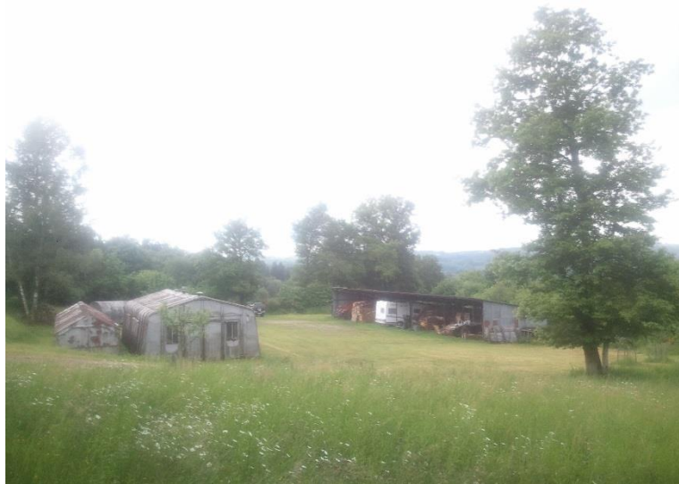
Figure 9 : Photographie du site et des bâtiments (2018)
